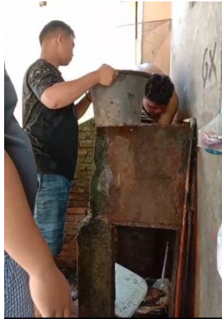
Gambar 3. Proses Penggantian Saringan
